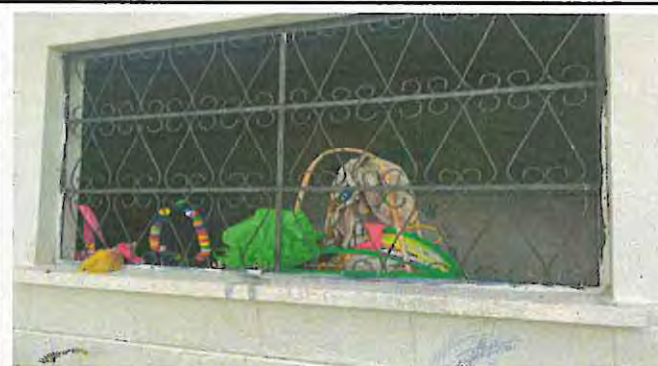
Foto 4: Mantenimiento de balcones en aula y bodega lijado y pintado
