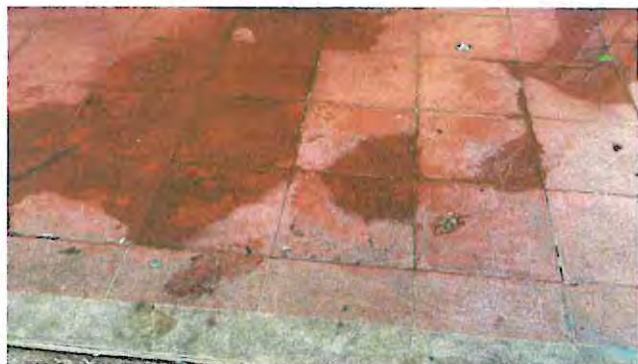
Foto1: Sustrucción de piso de granito por piso cerámico antideslizante en aula, bodega y corredor, por deterioro.
