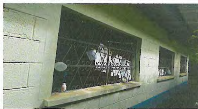
Foto 2: Implementación de ventanas de PVC, en aula y bodega, ya que solo se cuenta con balcones.
