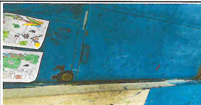
Foto 5: Mantenimiento de puertas de metal de aula y bodega ya lijado y pintura por deterioro.
