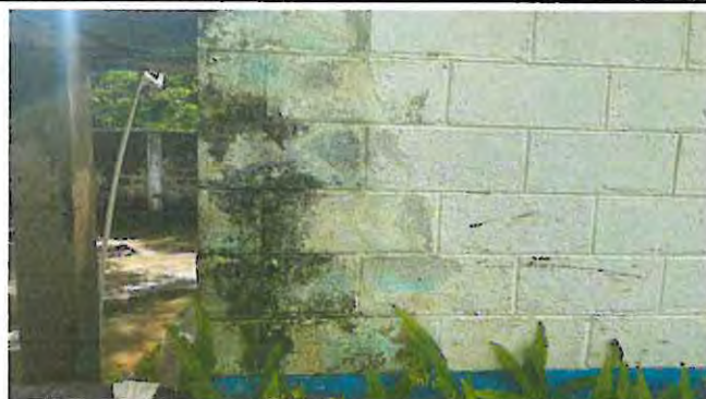
Foto 3: Pintura de muros interiores y exteriores de salón de clases y cocina pues la pintura ya está deteriorada.
