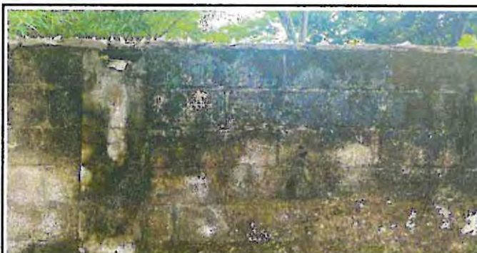
Foto 6: Reparación de muro perimetral de block con cernido ya que la humedad lo tiene deteriorado.
