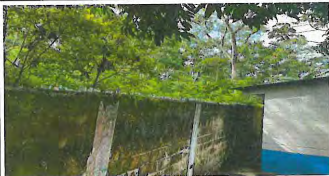
Foto 7: Reparación de muro perimetral de block con tubo hg y malla galvanizada ya que esta muy bajo y se entran a la escuela.
