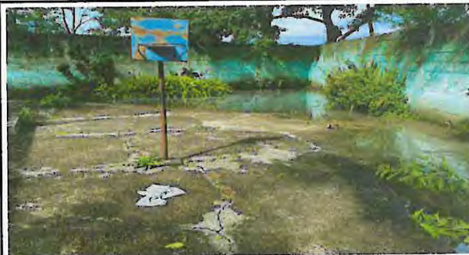
Foto 8: Reparación de losa de patio con espesor de 10cm ya que el existente se hundió y se emposa el agua.
